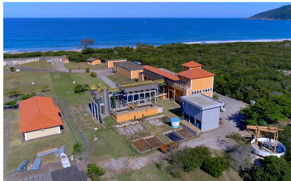
Estação de Tratamento da Lagoa do Peri
