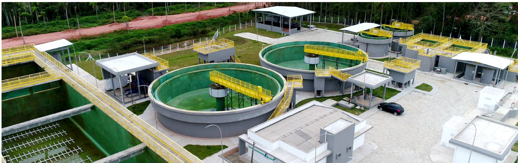
Estação de Tratamento de Esgoto Piçarras
