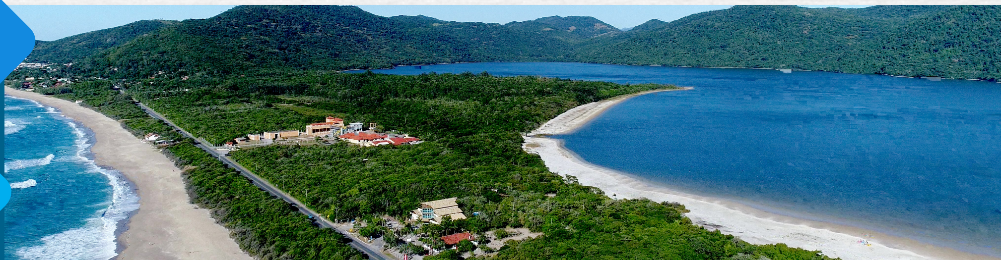
Estação de Tratamento de Água da Lagoa do Peri, Florianópolis
