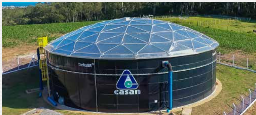
Reservatório de Içara
