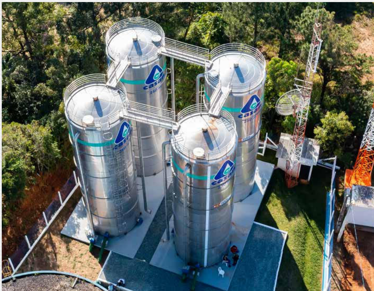
Reservatório Barra Velha
