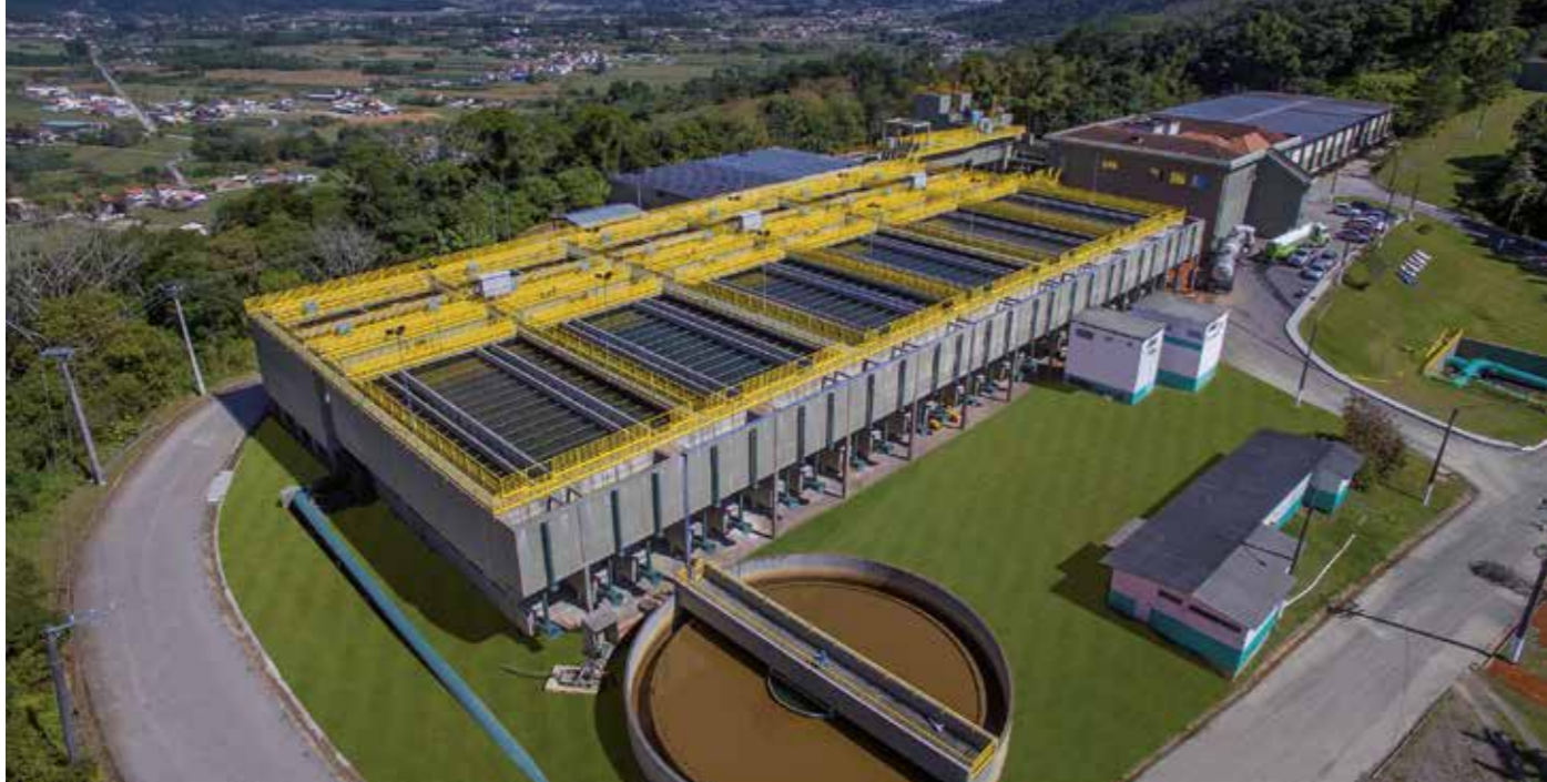
Palhoça: Floccodcantador do Sistema Integrado de Abastecimento de Água da Grande Florianópolis. Palhoça: Flocculator in the Integrated System of Water Supply at Greater Florianópolis.
