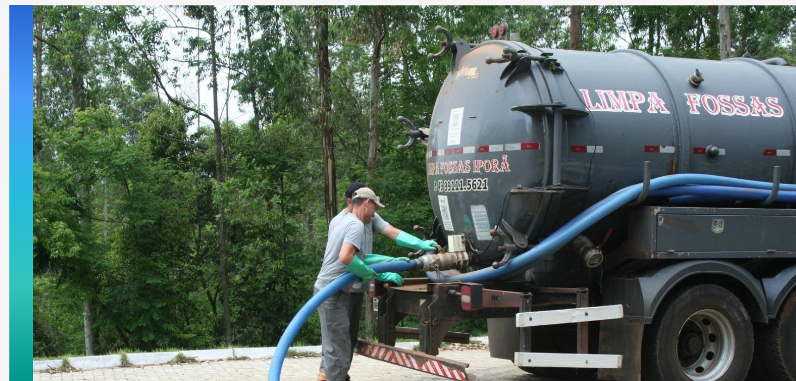
Figura 62 - Esgotamento Sobre Rodas
