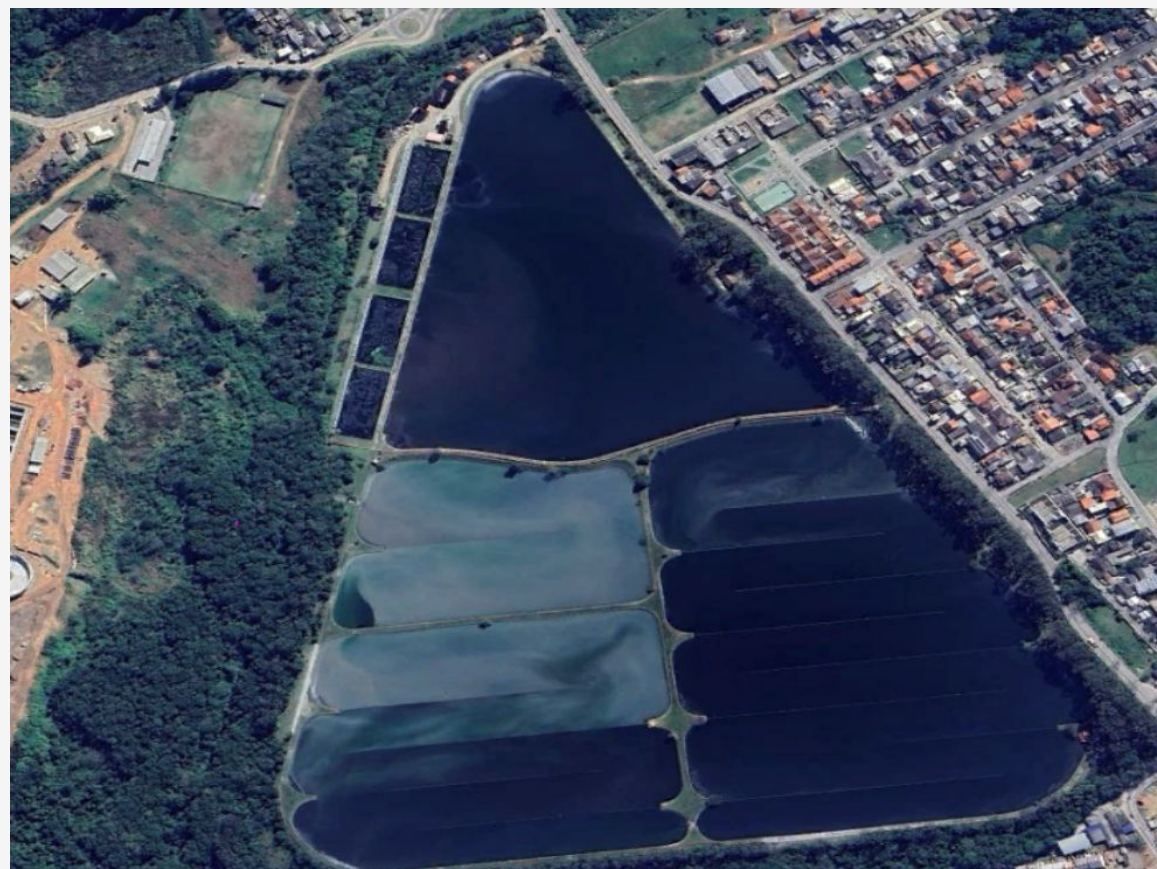
Figura 08 - ETE (Estação de Tratamento de Esgotos Potecas) - São José
